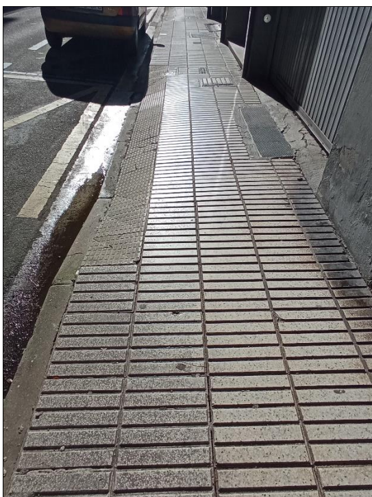
Estrechamiento de acera estrecha por realizar paso de carruajes en una de las filas de la acera en Irun kalea
