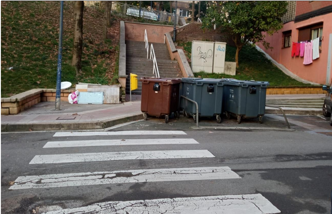
El paso de peatones no está ni rebajado ni señalizado y los contenedores ocupan la mitad del mismo en Jesus Guridi kalea
