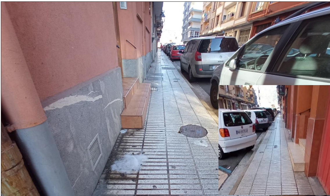
Astigarraga kalea. En algún caso, las aceras se estrechan además de por el mobiliario urbano por la presencia de escalones de acceso a portales
