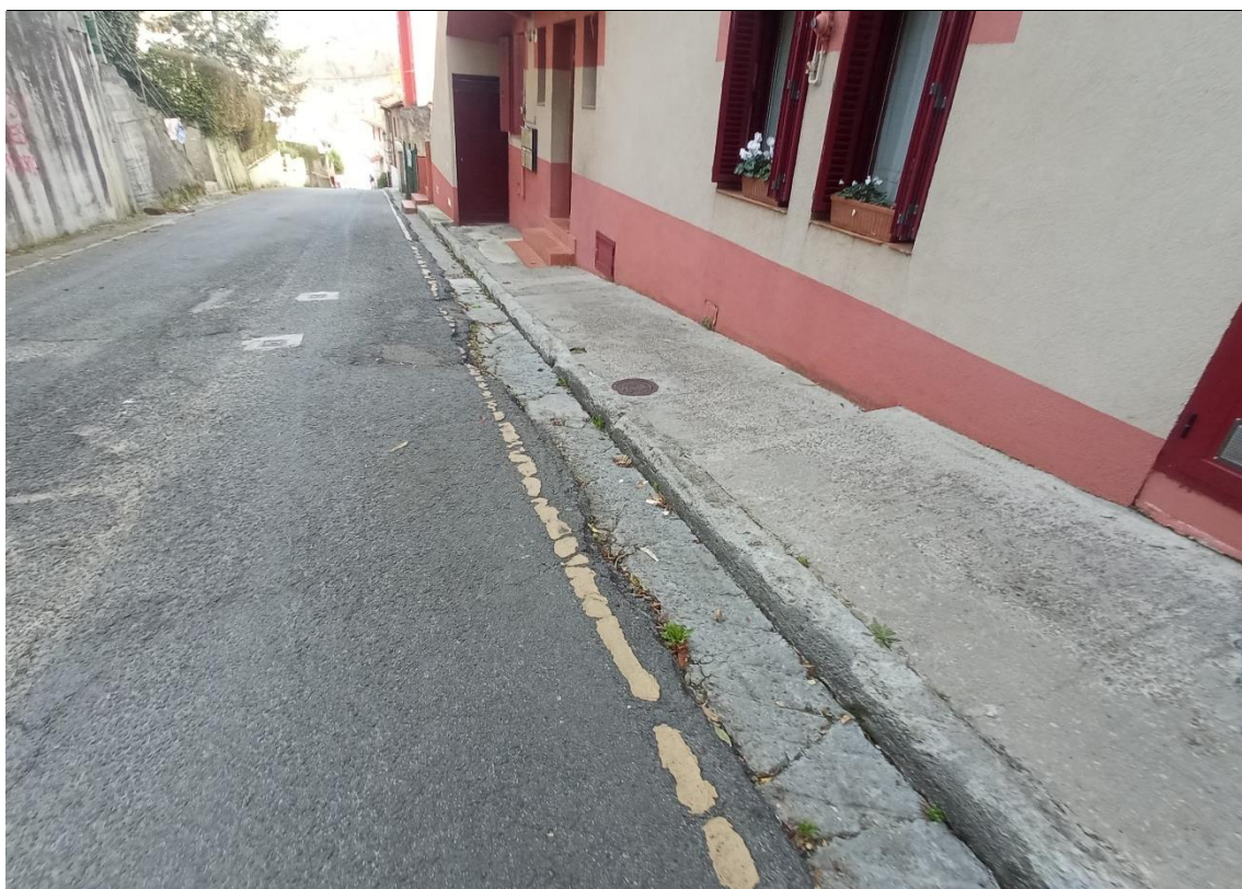
Reurbanización de Aldapa B
