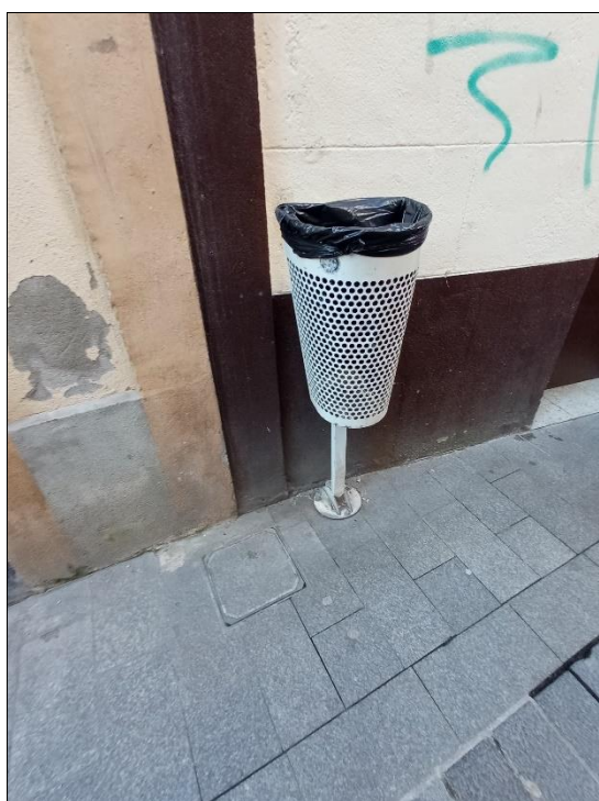
La papelera es inaccesible debido a que no se prolonga su sombra hasta en suelo (foto en Santxoena kalea)
