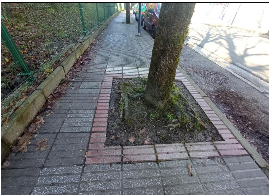
Los árboles y la inexistencia de cubrealcorque reducen la anchura de la acera aún mas en Touring
