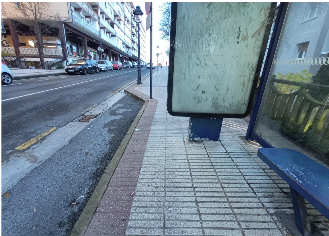
Interrupción del paso por el lateral de la marquesina en Galtzaraborda
