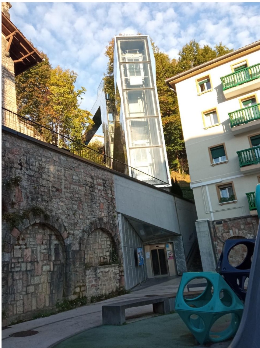
Ascensor Barrio Alaberga
