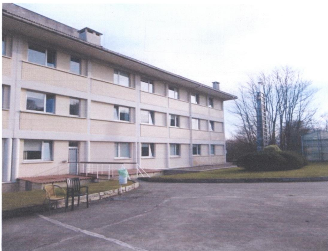
Imagen 3: Estado actual de la fachada exterior trasera del Gerontológico.
