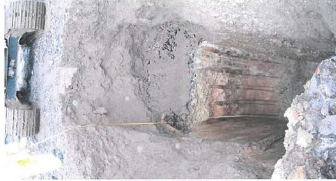
CALICATA C-6 PROFUNDIDAD FINAL = 5,50 MTS.
