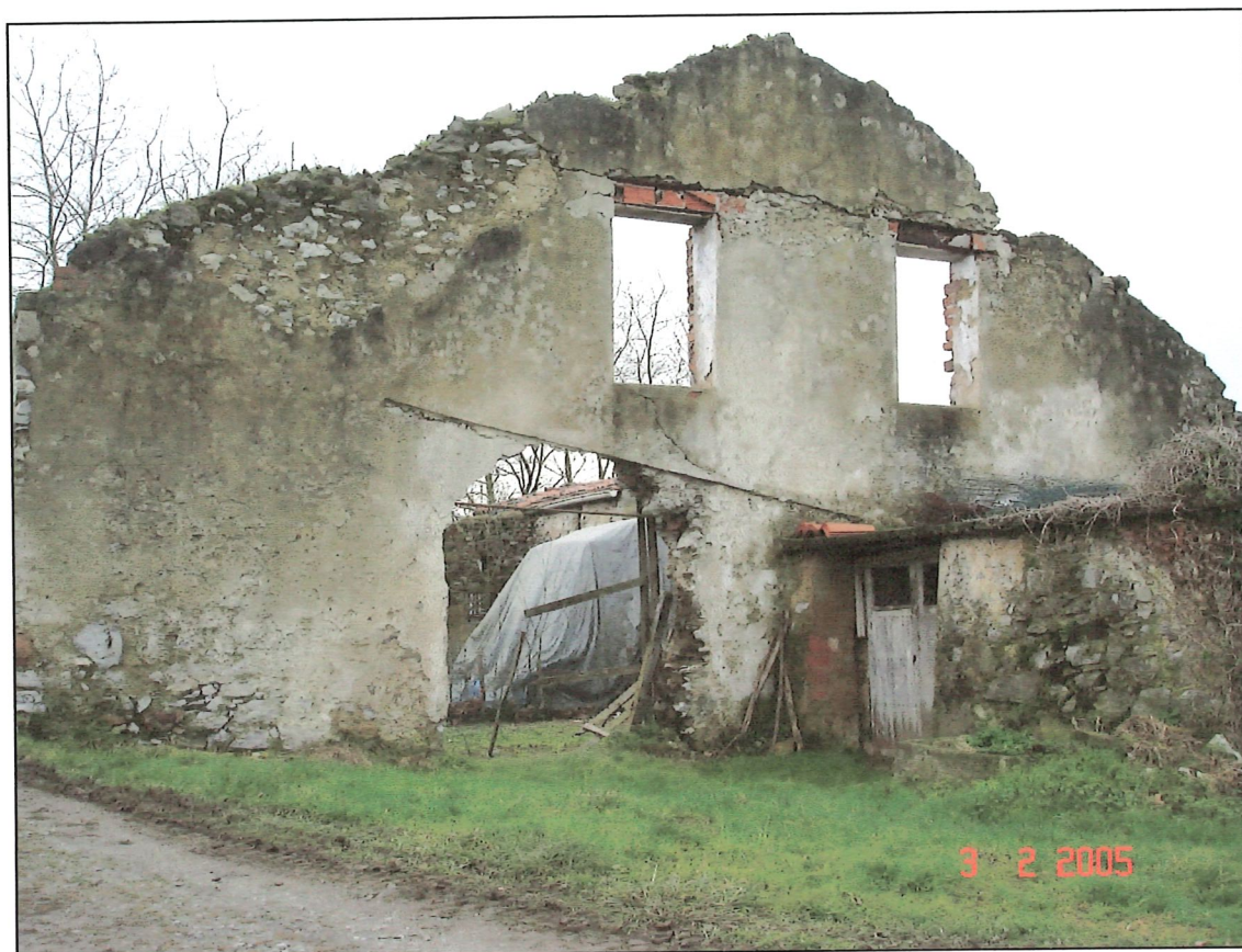
FOTO Nº7. VISTA DE LAS RUINAS DEL CASERIO AZAÑETA. FACHADA NORTE.
