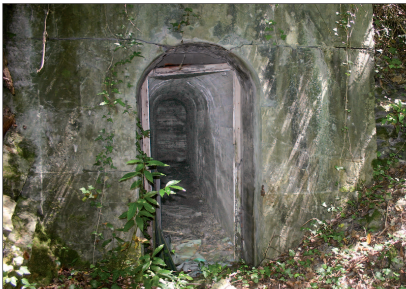
Fig. 47: Obra 25. Acceso en boca de mina visto desde el exterior.
