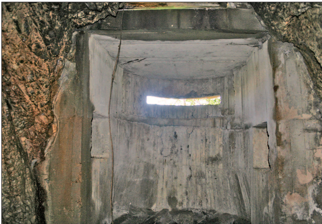
Fig. 59: Observatorio de Arkale. Emboquillado de la abertura de observación mediante un tambor de hormigón. Vista desde el interior.
