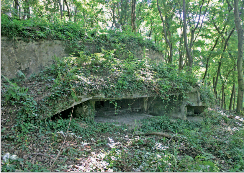
Fig. 40: Obra n. 23. Exterior del refugio activo.
