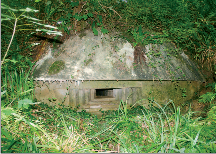
Fig. 13: Exterior de un nido de ametralladora de la obra n. 6. Puede apreciarse claramente la aspillera y el camuflaje de vegetación.
