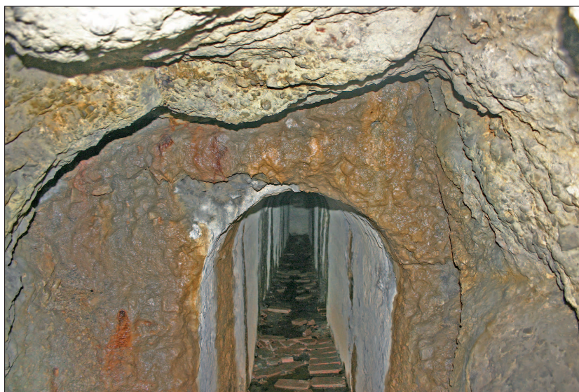
Fig. 57: Observatorio de Arkale. Tercer tramo de la bocamina A. La mitad del mismo está revestido de hormigón, formando bóveda y la otra mitad está excavado en la roca. En la fotografía se puede contemplar el paso entre uno y otro sectores.
