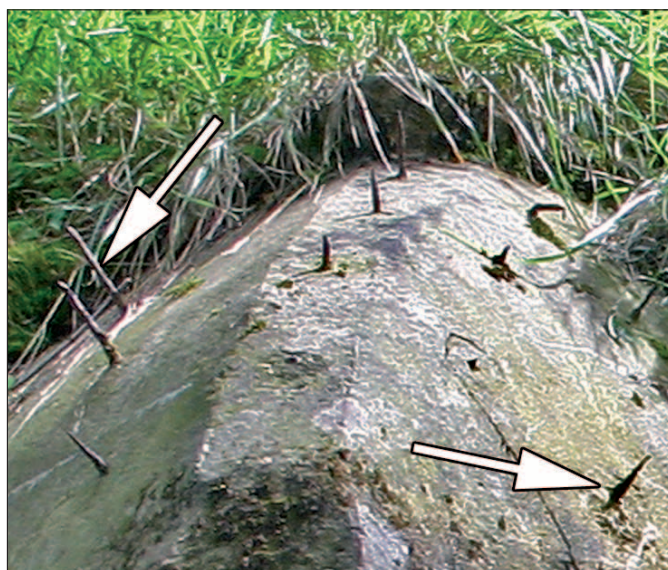
Fig. 12: Varillas de ferralla que sobresalen de un nido de la obra n. 23 (dos de ellas se señalan con flechas). Su misión es retener tierra y vegetación para evitar ser identificado en fotografía aérea. Las varillas aparecen actualmente con diverso grado de oxidación y, según la documentación, pudieron poseer una espiral final, a modo de sacacorchos, que aumentase el grado de retención.
