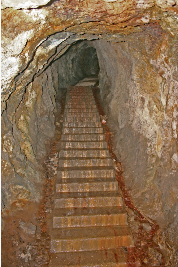
Fig. 58: Observatorio de Arkale. Tramo ascendente mediante escalera, sin que presente revestimiento de hormigón.
