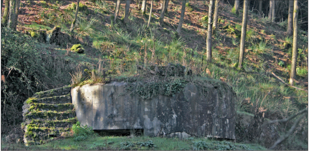
Fig. 43: Obra n. 24. Vista exterior de un nido de ametralladora (Vid. fig. 42, letra F). Es claramente visible por no estar camuflado, debido a que es una obra inconclusa. Se aprecian también las alas laterales, escalonadas, realizadas en mampostería, destinadas a contener las tierras.
