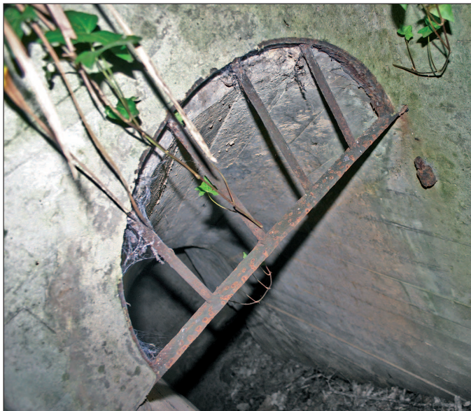
Fig. 34: Obra n. 6. Restos del cierre mediante verja de los pozos de tirador. Se ha conservado la parte fija que cierra el sector superior, mientras que el inferior tomaría la forma de puerta.
