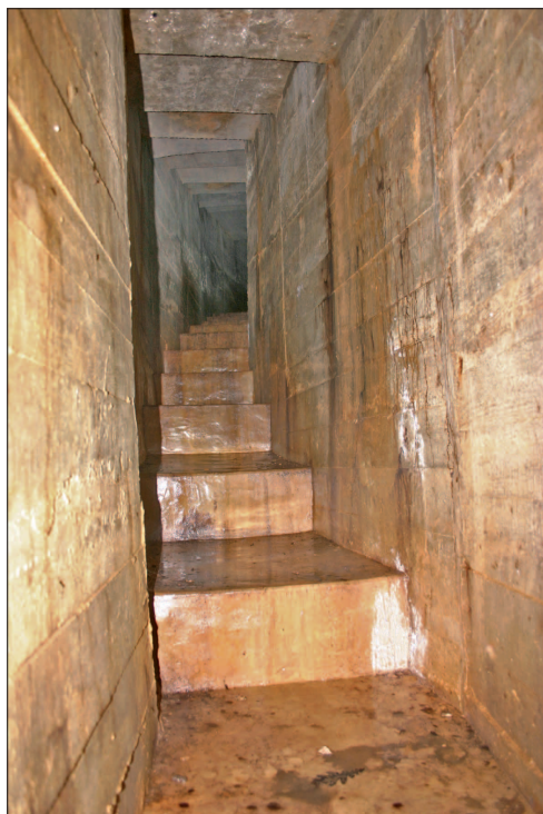
Fig. 7: Galería adintelada de la obra n. 2.
