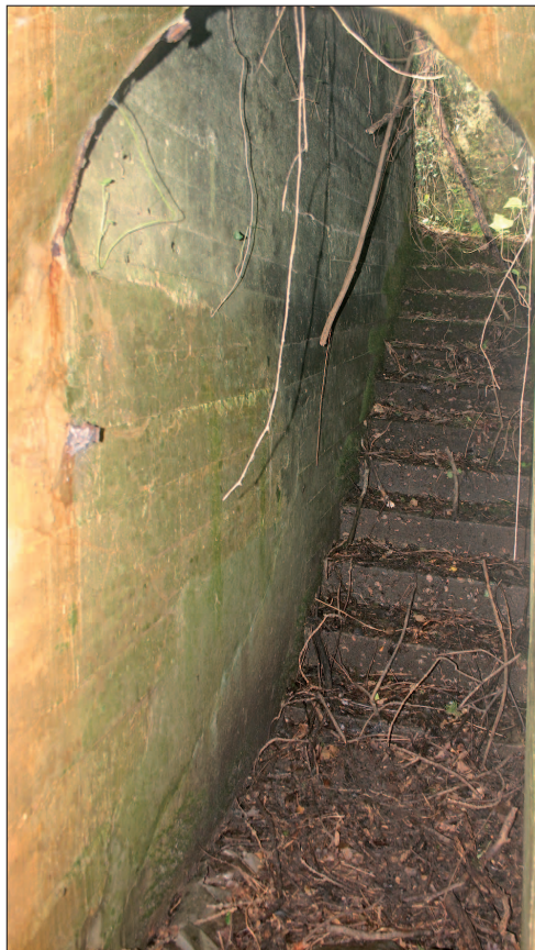
Fig. 24: Acceso a la obra n. 3, visto desde el interior. El descenso tiene lugar por medio de una docena de escalones.
