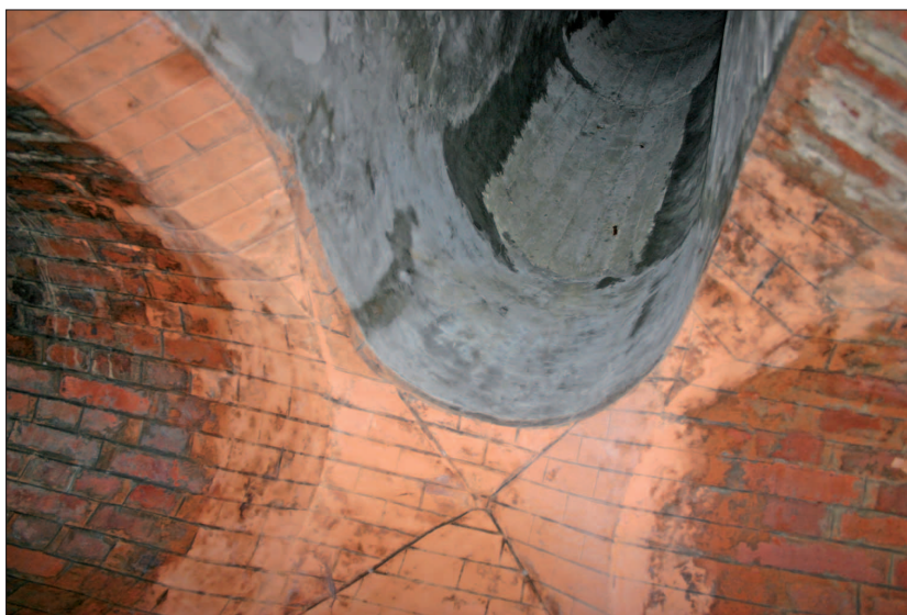
Fig. 48. Obra 25. Cruce de las bóvedas de la galería principal (de ladrillo en este sector) y de acceso al refugio (de hormigón). Corresponde al punto W del plano.
