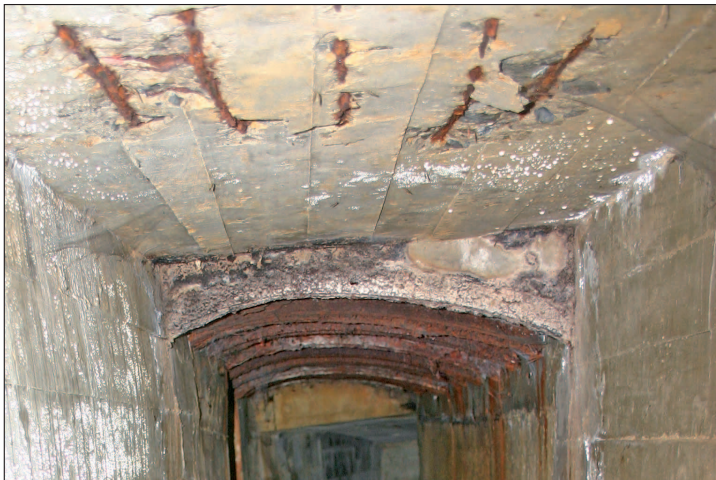
Fig. 21: Obra número 2. En primer plano, el techo adintelado de la galería y en segundo plano, un sector de bóveda muy rebajada reforzada por viguetas metálicas.
