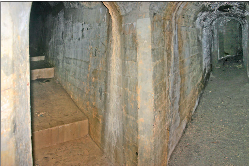
Fig. 33: Obra n. 6. Cruce de ramales de galería. La de la derecha, llana (Vid. Fig. 30 sector CA) y la de la izquierda, escalonada (Vid. Fig. 30 sector CE).
