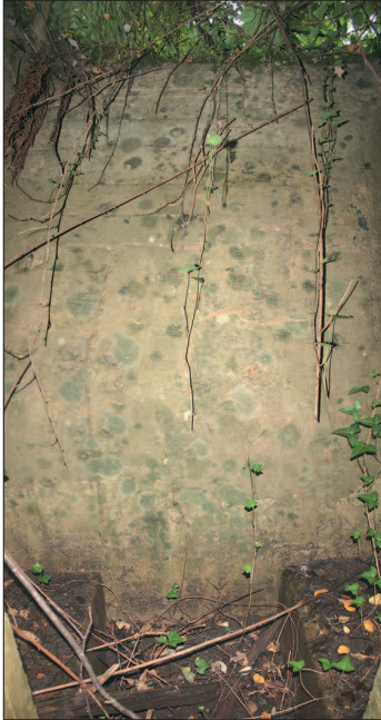
Fig. 4: Fotografía en contrapicado de un pozo de tirador de la obra número 2. A ambos lados pueden apreciarse las banquetas para facilitar el disparo.
