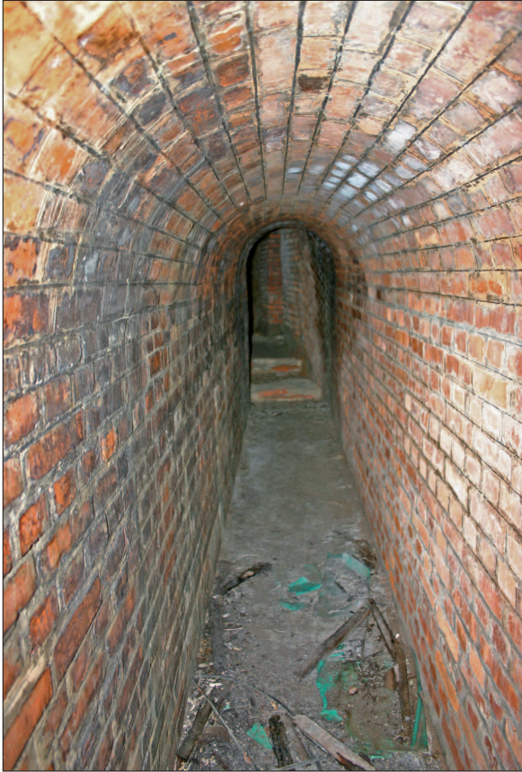
Fig. 8: Galería abovedada revestida de ladrillo. Corresponde a la obra n. 25. Incluso algunos escalones están confeccionados de ladrillo revestido de mortero.
