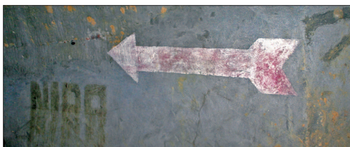
Fig. 11: Rotulaciones en las paredes de las galerías de la obra n. 6. Realizadas con pintura sobre el hormigón, indicando la dirección hacia la que se encuentran algunas dependencias (nidos, tirador, etc.).
