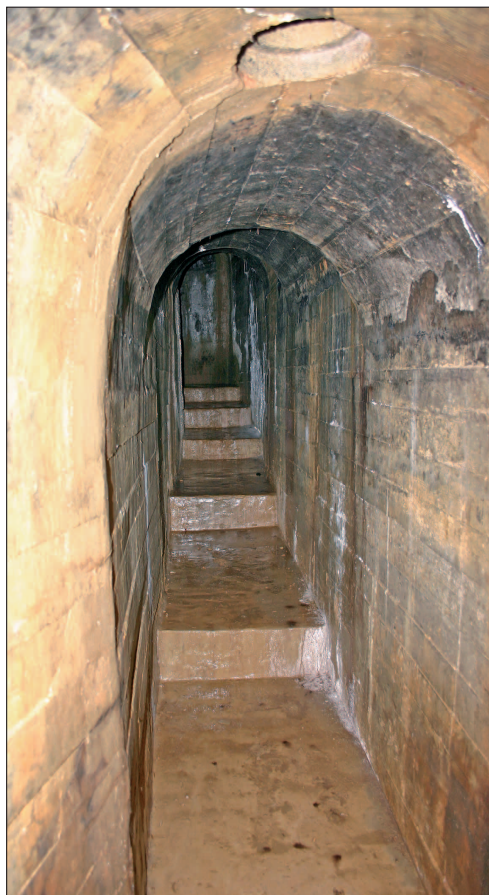
Fig. 6: Galería abovedada de la obra n. 5. Nótense los escalones y el orificio superior.
