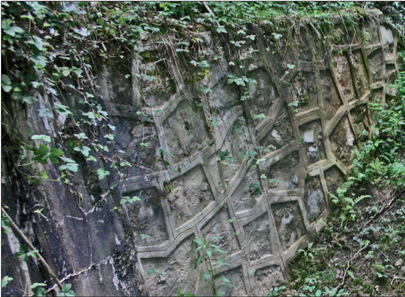
Fig. 41: Obra n. 23. Detalle de la imitación a mampostería encintada, probablemente con objeto de evitar la reflexión solar del hormigón liso que podría descubrir la obra a la fotografía aérea.
