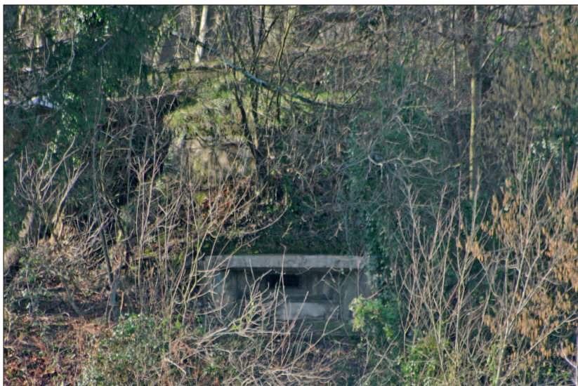
Fig. 35: Obra n. 9. Vista exterior de una de las aspilleras del fortín.
