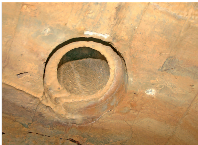
Fig. 10: Orificio (correspondiente a la obra n. 6) destinado probablemente a la ventilación de la obra en caso de guerra química. Se basaría en el cierre de entradas y aspilleras mediante lonas y el filtrado de aire mediante conductos como el de la fotografía, que desembocarían en un filtro "natural" formado un una pequeña fosa llena de tierra vegetal sin apelmazar.
