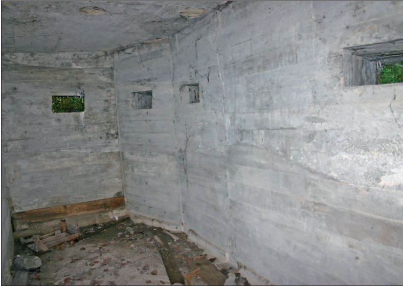
Fig. 49. Obra 25. Interior del refugio activo. Está desprovisto del encofrado y se aprecian en la fotografía cuatro de las cinco aspilleras que posee. Nótese que los refugios no poseen el resalte perimétrico que tienen los nidos.
