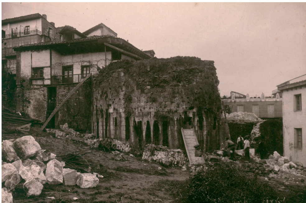
Obras del derribo del baluarte a inicios del siglo XX, tal y como las fotografió Eugenio Figurski (Imagen: Archivo Municipal de Errenteria).
