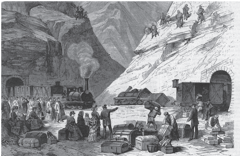
ÉVÉNEMENTS DE D' ESPAGNE. Rupture du chemin de fer par les carlistes entre Alsasua et Zumárraga.
