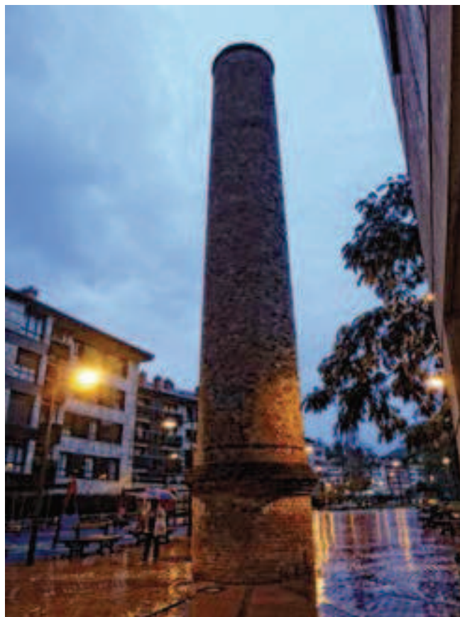
Chimenea en recuerdo de la antigua Fabril Lanera, hoy Plaza de los Pueblos Hermanados. (Fotografía: Zaida Fernández)
