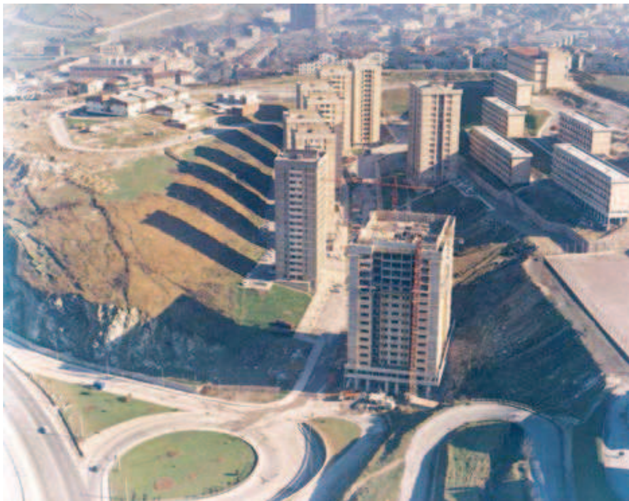
Obras de construcción del barrio de Capuchinos en los años 1973 y 1974. (Fuente: Archivo Municipal de Errenteria A015F201).
