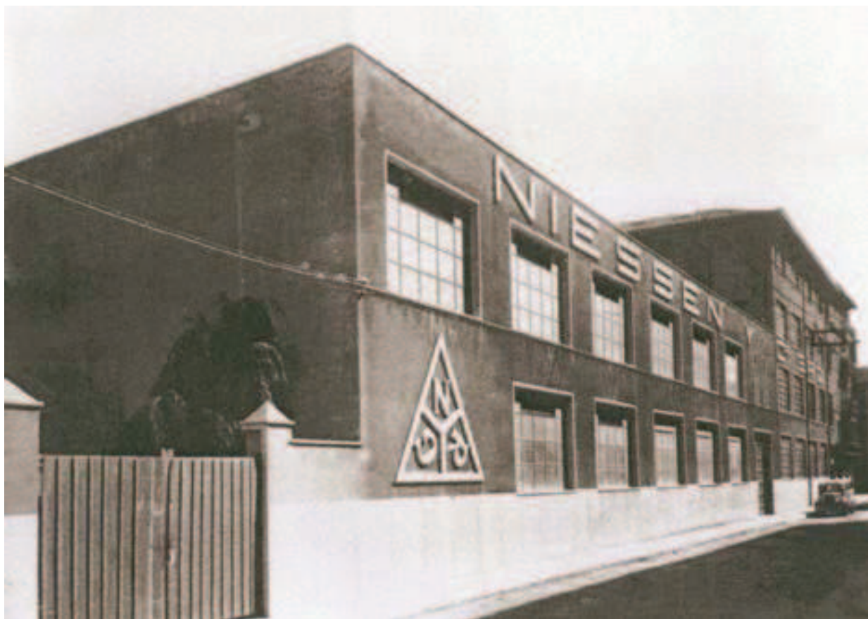
Fachada a la calle Alfonso XI en el año 1955. (Fotografía: Archivo Municipal de Erreterria A006F041).
