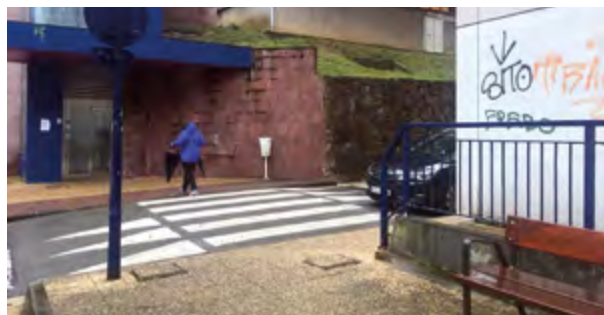
145. irudia. Basanoaga kalearen fatxadetako bat eremu maldatsuan eraiki ahal izateko egin zen karga horma batek osatzen du, aipatutako fatxada itsuak sortuz. Egilea: Itsaso Larramendi Elexgaray.
