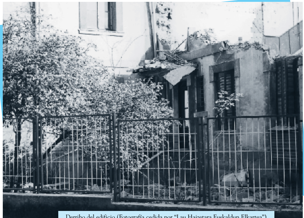
Derribo del edificio (Fotografía cedida por “Lau Haizetara Euskaldun Elkarte”)
