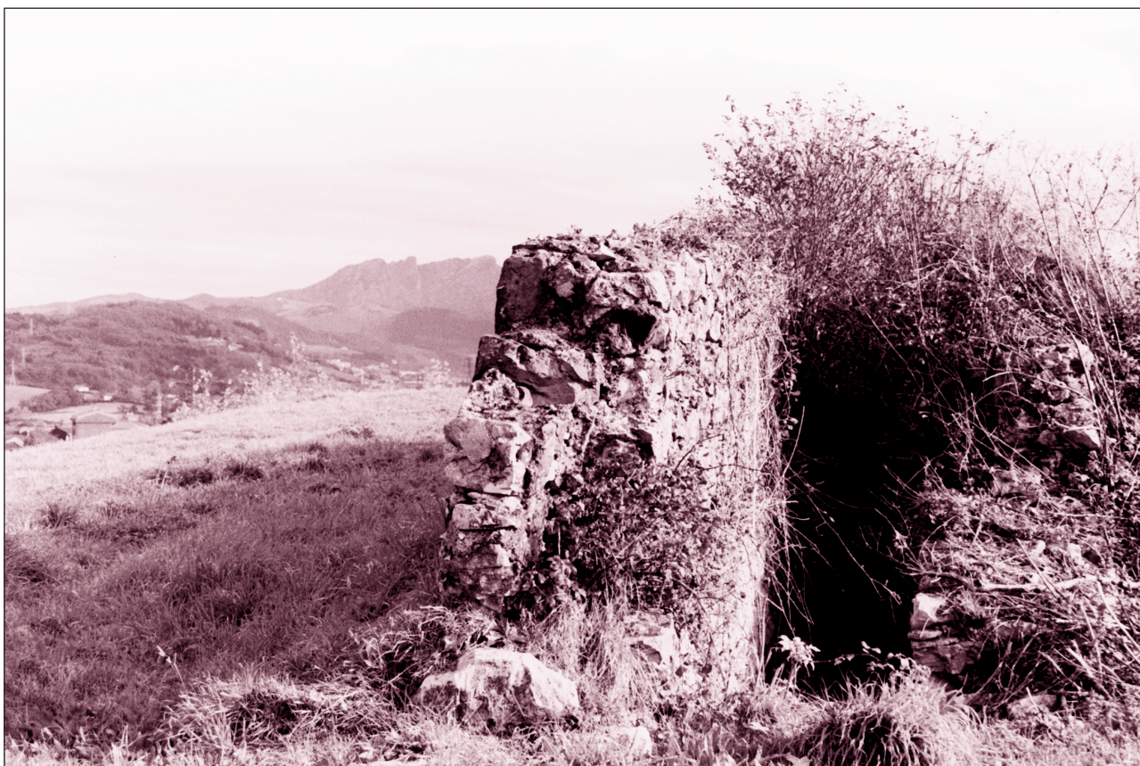
Vista del muro de la semicapenera oriental del fuerte de Arramendi, al fondo Peña de Aia
