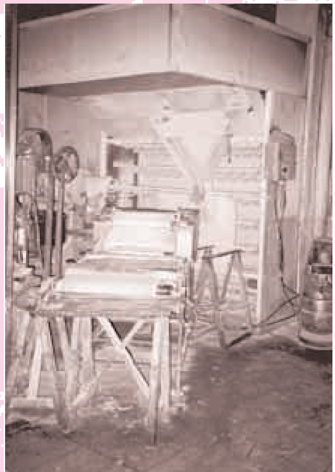
Quienes sepan del oficio reconocerán en esta fotografía la artesa, la reposadora, la formadora y la divisora.
