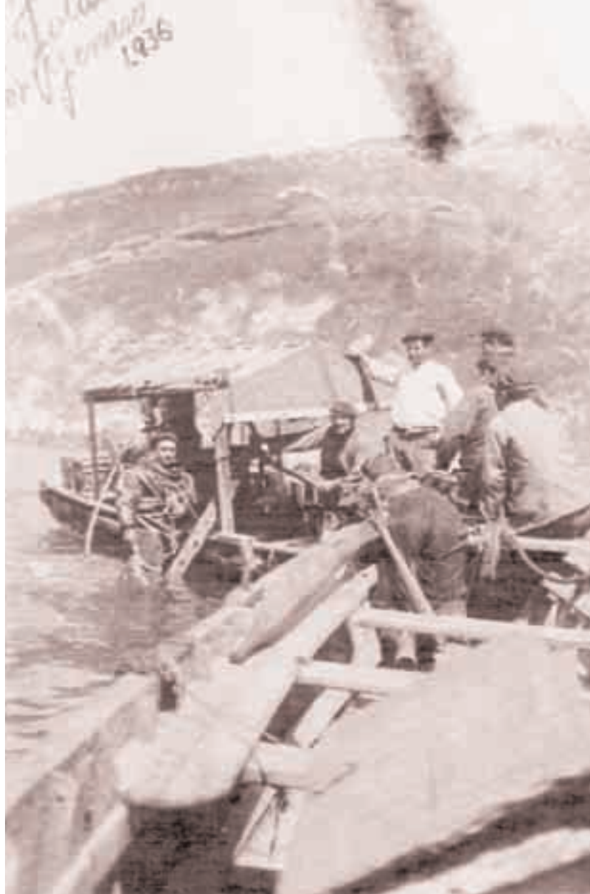
Preparativos para el desguace, por Genaro Mancisidor, del buque Jatamendi hundido en cala Bursa, Pasaia, en 1936.
