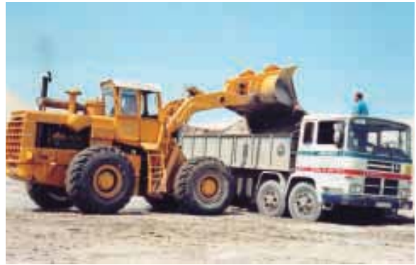
Nº 43: Arenera de Plaiaundi. La excavadora Internacional cargando arena de ría al Pegaso SS-2426-F
