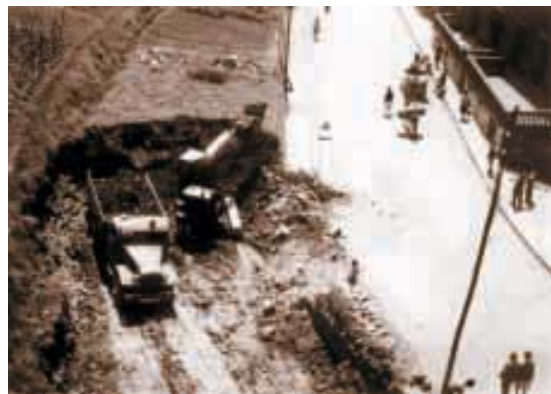
N° 48: Inicio del desmonte, en 1960, en el actual número 23 de la calle María de Lezo. En la Fotografía: la primera excavadora Yumbo (comprada en la Feria de Burdeos) cargando al GMC
