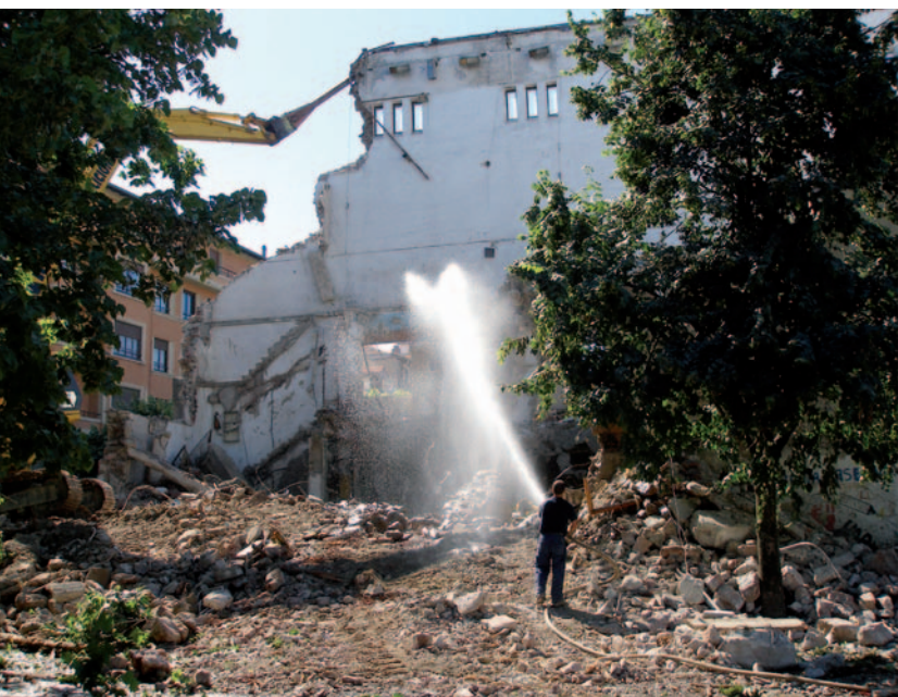
14 de junio: Derribo del batzoki .
