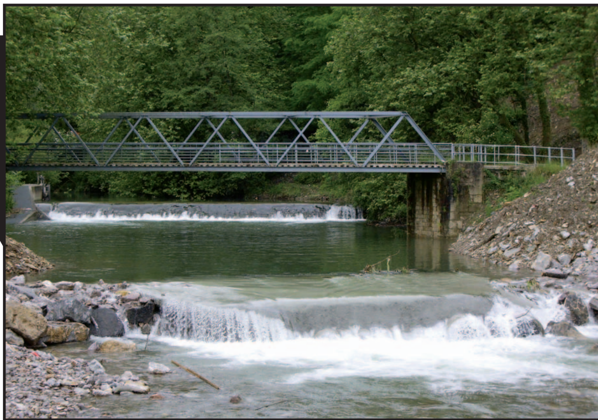
Situación actual del "Puente Peligroso" y Aranguren
