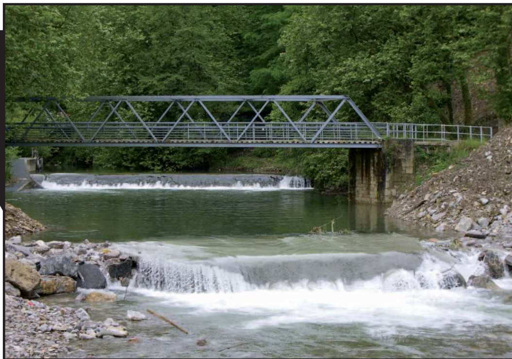
Situación actual del "Puente Peligroso" y Aranguren
