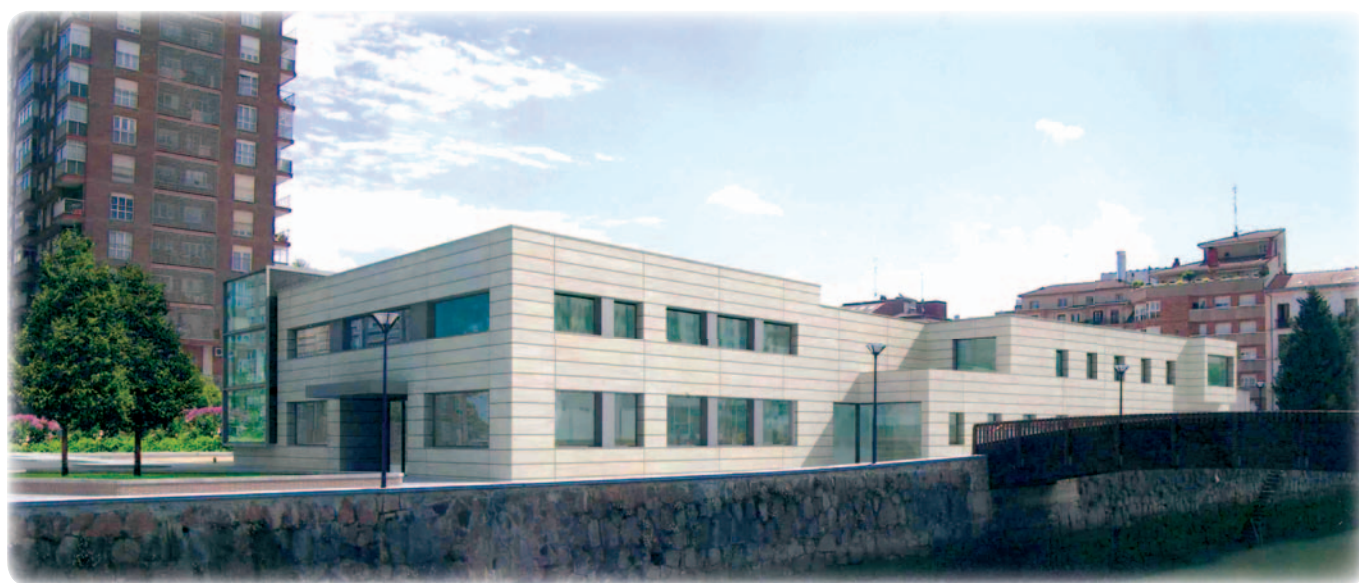
Vista exterior. Vista del edificio desde el río (fachadas sur y oeste).
