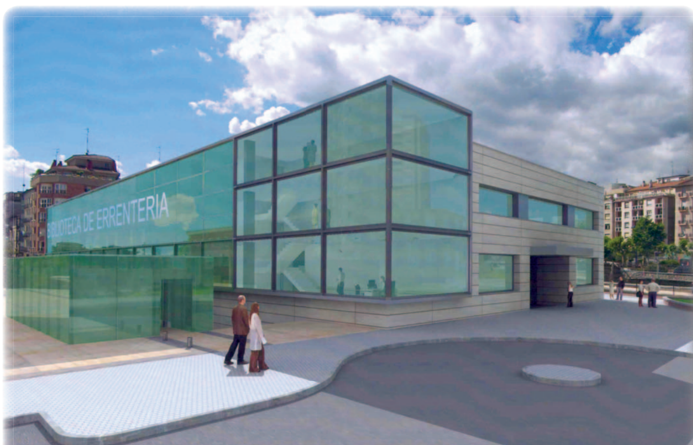
Vista exterior. Vista del edificio desde la plaza (fachadas norte y oeste).
