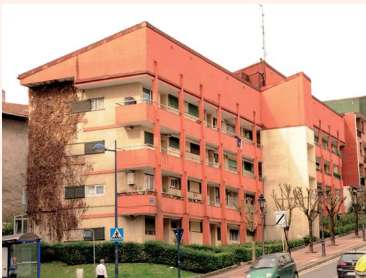
La casa de la Avda. de Galtzaraborda nºs. 1 y 3, con su esquema general de "corrala" servido por sutiles modificaciones del nivel de las plantas. El volumen independiente adosado sobre el frente de fachada contiene la escalera de acceso a los pisos.
