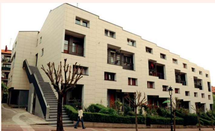
Fachada sur de la casa proyectada en el lado de los números pares de la Avda. de Galtzaraborda. En primer término, la escalera que conduce a la galería desde la que se accede a los apartamentos en dúplex altos. Obsérvese la sutil adecuación a la pendiente del terreno.
