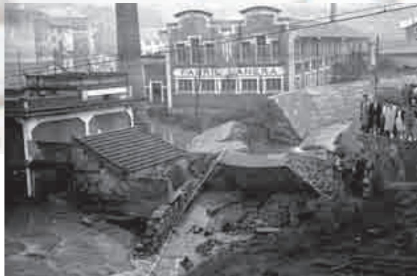
Rotura canalización de la regata de Pekin, Tintorería.
