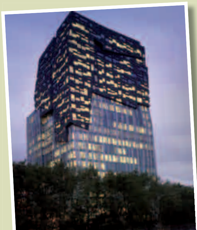
Mahler 4 Tower, Amsterdam, Países Bajos. Edificio de oficinas para Blackstone+de Brow. EEA Erick van Egeraat Associated Architects, Rotterdam. Erick van Egeraat, Massimo Bertolano, Roemer Pierik, Iñaki Arbelaiz, Rudolph Eilander, Patricia Mata, Lucía Ortiz, Aude de Brossia, Steven Simmons, Cock Peterse, Frank Huibers, Peter Foldi, Mette Rasmussen, Fabiana Toni.
