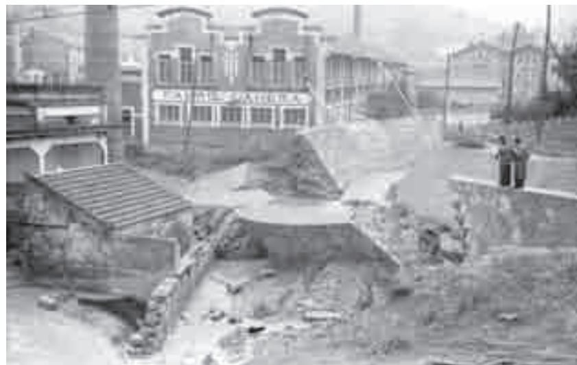
Rotura canalización regata de Pekin. Tintorería.
