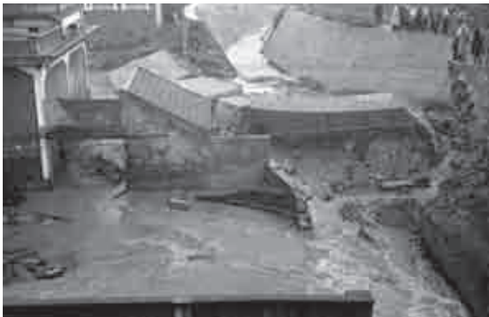
Detalle rotura canalización regata de Pekin.
