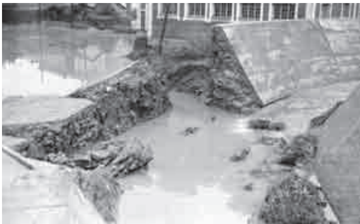
Detalle rotura del canal de la regata de Pekin.
