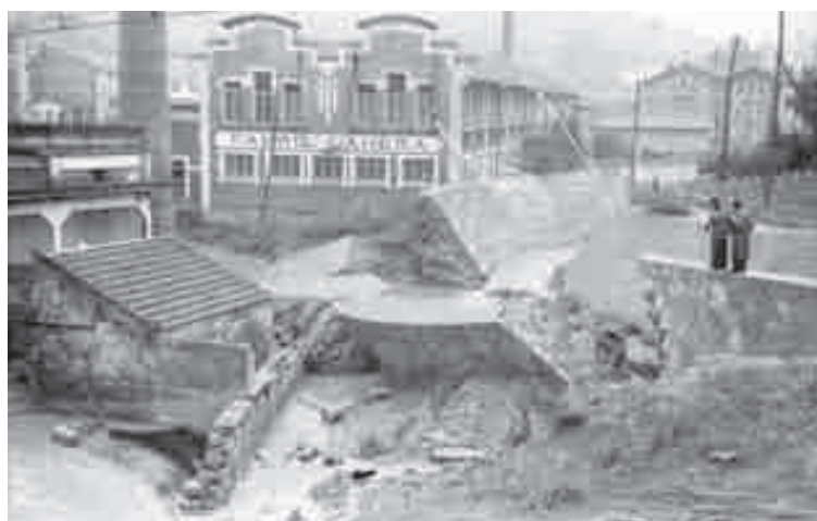
Rotura canalización regata de Pekin. Tintorería.
