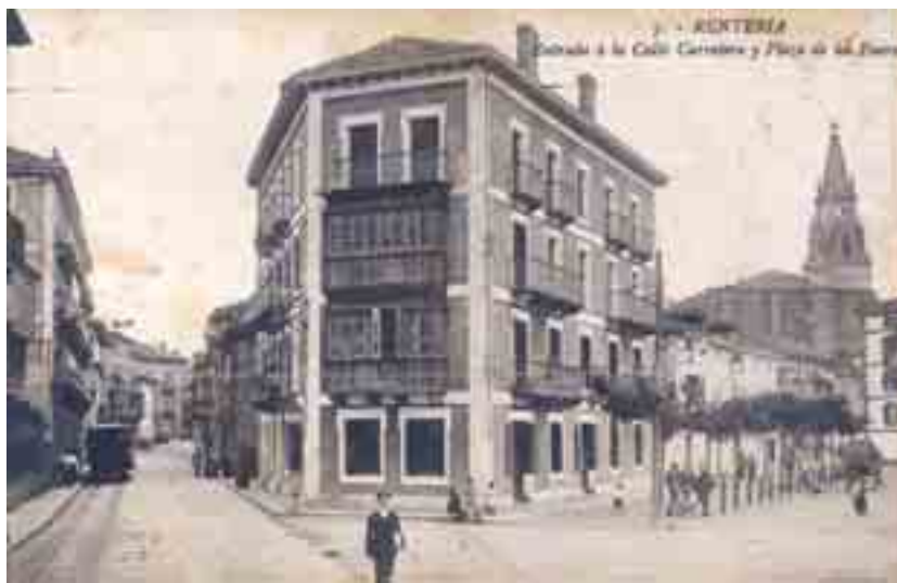
Entrada a la calle Carretera y plaza de los Fueros.
