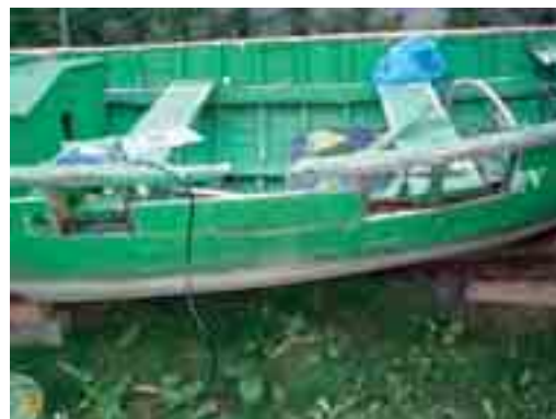
Extracción de forro y maderas deterioradas para ser sustituidas.
