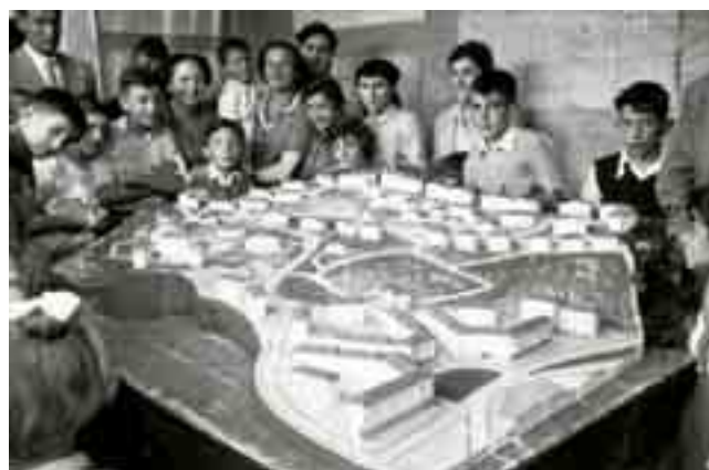
Ilustración nº 5: La maqueta del Poblado de Alaberga (que ya no es la de la ilustración nº 4), rodeada hacia 1950 por la chavalería renteriana de entonces que sonríe, ilusionada, ante las promesas del Régimen.
