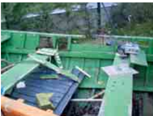
Elementos deteriorados en proceso de sustitución.
