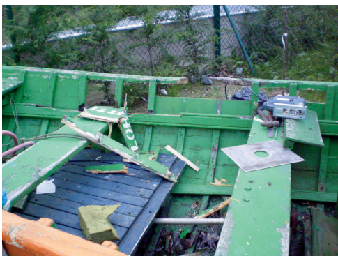
Elementos deteriorados en proceso de sustitución.
