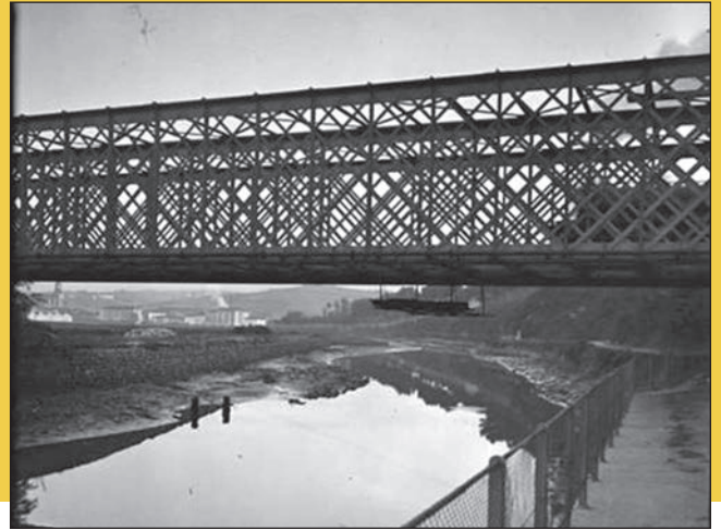
Guipúzcoa VI. Caja 75. [Viaducto de Lezo]. DCP-A-1020.
