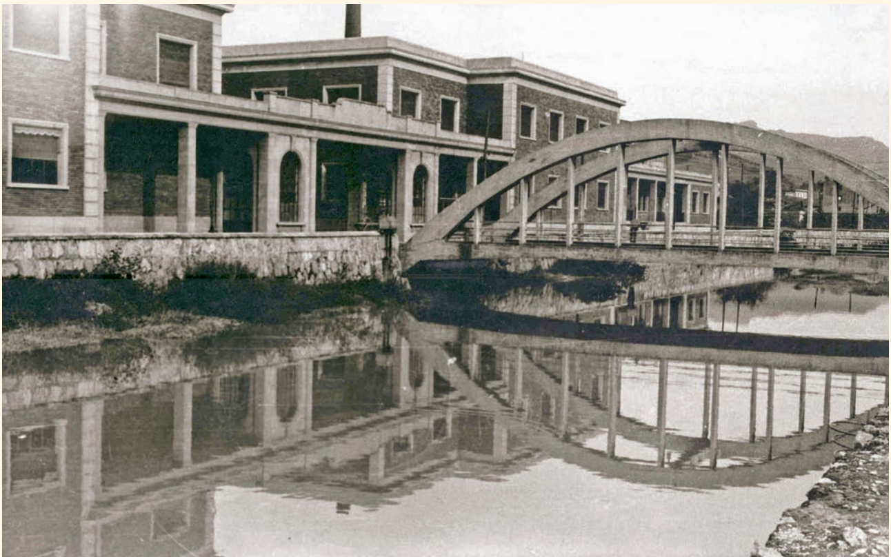
Vista del denominado popularmente “puente de La Papelera” sobre el río Oiartzun, hacia 1960.
