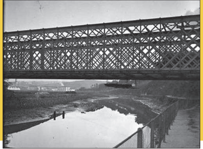
Guipúzcoa VI. Caja 75. [Viaducto de Lezo]. DCP-A-1020.
