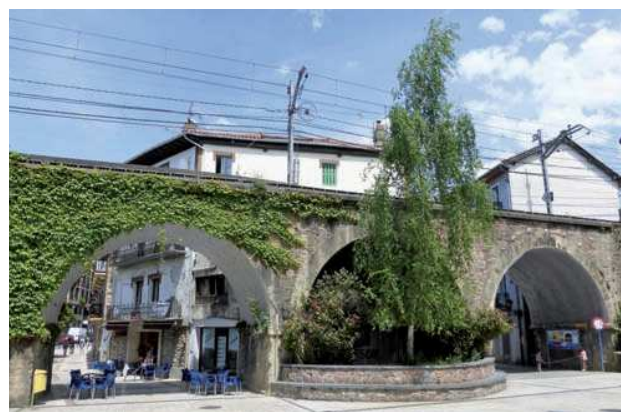
Fotografía actual del viaducto que se había proyectado por Horacio de Azqueta en 1910. (Fotografía: Ana M a Benito Domínguez).
