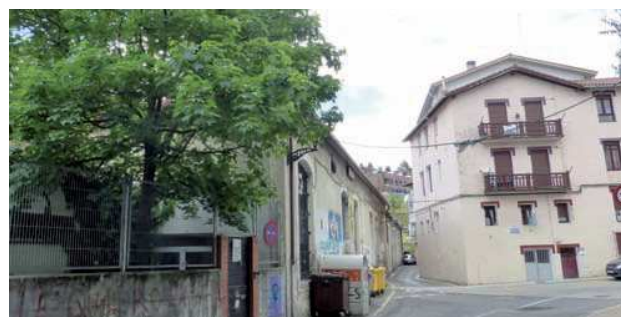
El caserío Gaztañedo en la actualidad, junto al edificio de las cocheras del Topo. (Fotografía: Ana M a Benito Domínguez)
