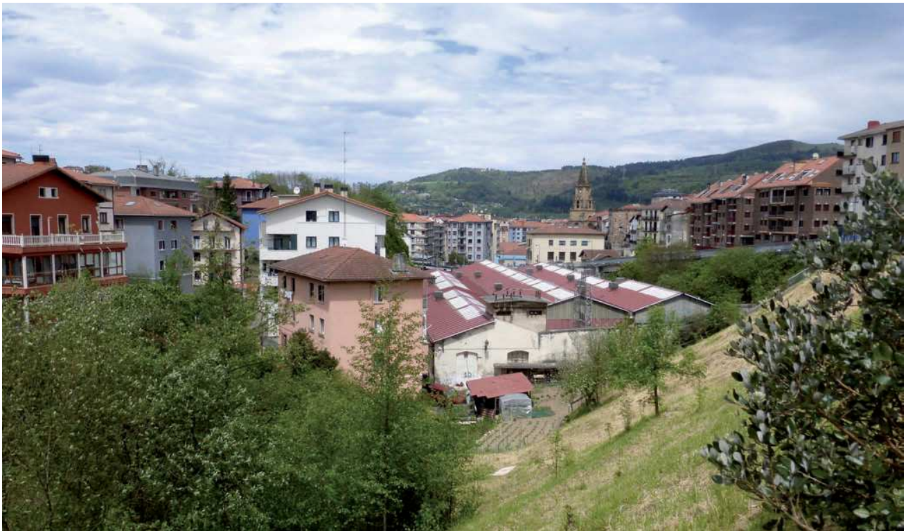
Imagen actual de las viejas cocheras de la estación del Topo, insertadas entre el barrio Gaztaño y el antiguo cementerio. (Fotografía: Ana M a Benito Domínguez).
