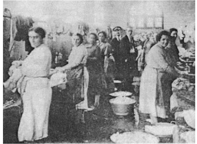
Lavadero construido en las proximidades de la estación de la frontera. (AME A014F070)
