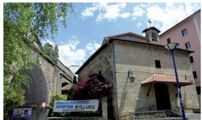
Edificio de la ermita de la Magdalena, cuya sacristía permanece debajo del viaducto proyectado por Horacio de Azqueta en 1910. (Fotografía: Ana M a Benito Domínguez)
