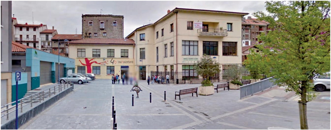
Situación del lavadero de la estación de la frontera
