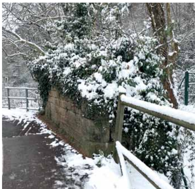
Base del puente peli, 28 de febrero de 2018.
