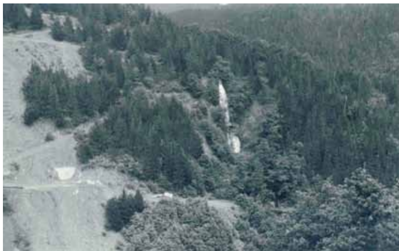
1973. Vista general del embalse de Añarbe. Fotografía: EUA-AME (A012 F139).
