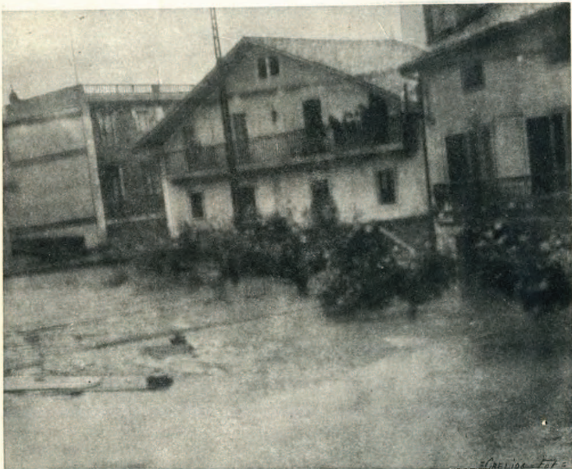
Aspecto de la Plaza de los Fueros durante la inundación
