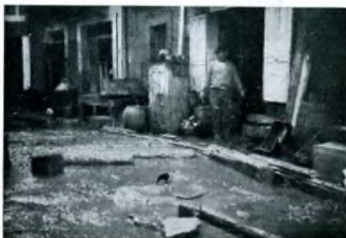
Primeros trabajos de limpieza en la calle de Vicente Elícegui
