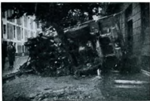
Estado en que quedó un camión arrollado por las aguas en la calle de Viteri.
