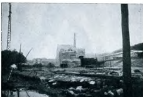
Así quedó el depósito de troncos de madera de la Papelera Española, donde derribado el muro de separación de la carretera, las aguas arrastraron miles de toneladas de troncos, allí apilados.
