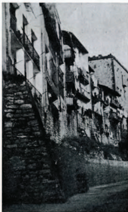
Restos actuales de la antigua muralla de Rentería, que desde «TORRE MORRONTXO» descendía hasta el mar. Como puede apreciarse, sobre sus cimientos se edificaron las casas de la calle Arriba.
