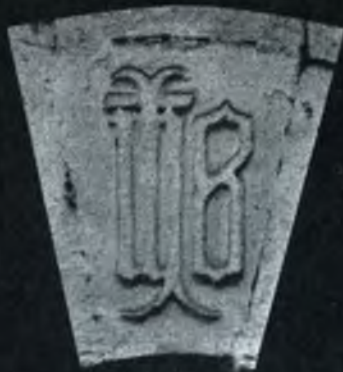
En la calle del Medio, 9 bis. En su sencillez se aprecia su antigüedad y solera, igual que la casa en que se halla.
