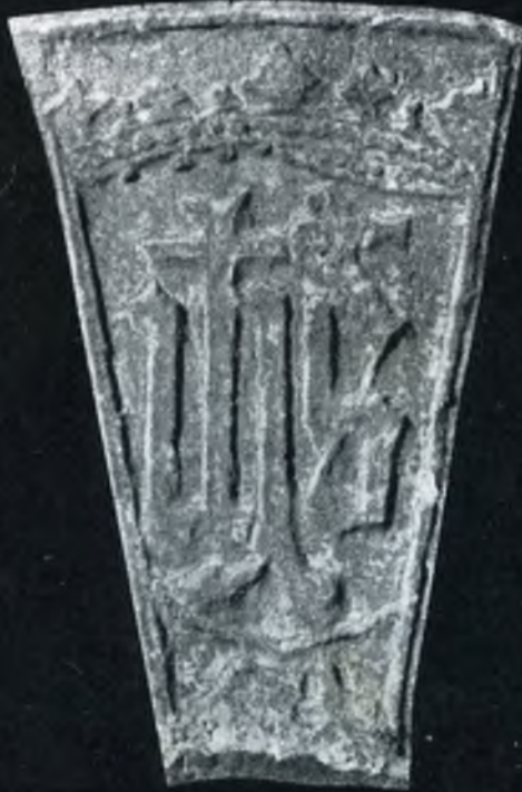
Sobre la puerta ojival condenada, en el "tarte de Txikito", calle de la Iglesia, 1. Ha sido muy mal tratado en su conservación. Los revoques y pinturas, casi han hecho desaparecer su relieve.
