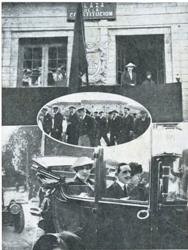
Las fiestas patronales de Rentería se han visto este año honradas con la presencia de SS. MM., que han asistido al acto inaugural de las obras del nuevo ramal de la carretera a Francia, en los alrededores de dicha villa. Nuestras fotografías representan: 1. SS. MM. en el balcón del Ayuntamiento saludando al pueblo renteriano, que tributo a las augustas damas entusiastas aclamaciones. 2. Comisión de la Diputación provincial y autoridades de Rentería, dirigiéndose a visitar la nueva carretera. 3. SS. MM. recorriendo en automóvil el ramal de carretera, nuevamente construido. (Fot. Merda)
