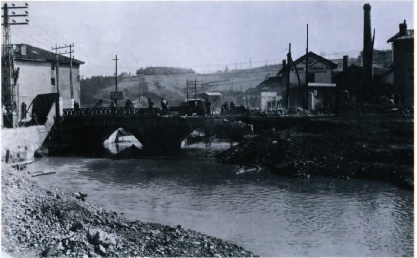
Derribo del viejo puente de Santa Clara, con motivo de la canalización del Oyarzun.
