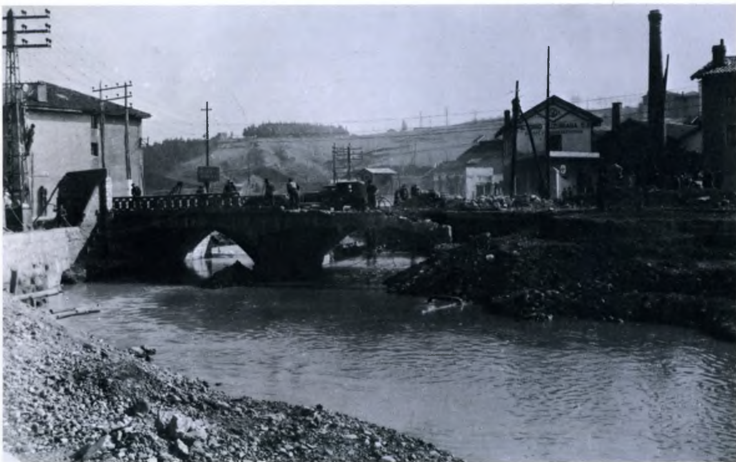
Derribo del viejo puente de Santa Clara, con motivo de la canalización del Oyarzun.
