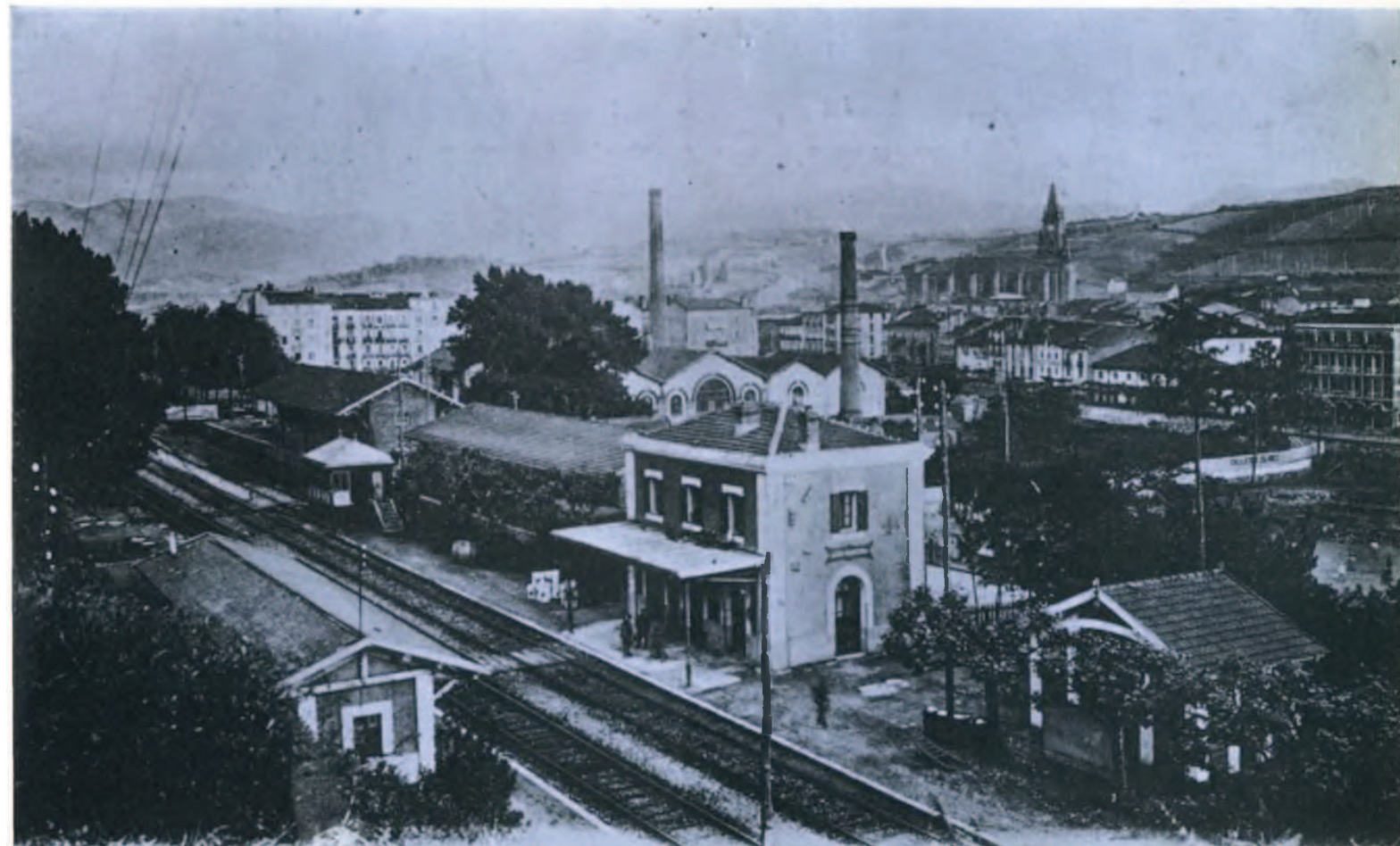
Ni Rentería ni la calle de Viteri son en la actualidad como nos muestran estas fotografías. ¿Hace falta decirlo?
