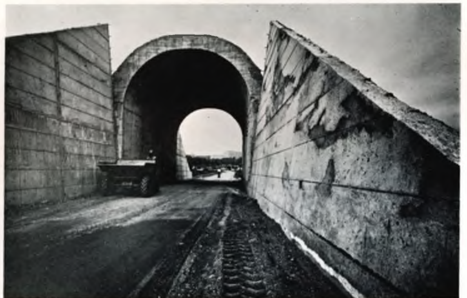
Obra para paso superior de camino.
