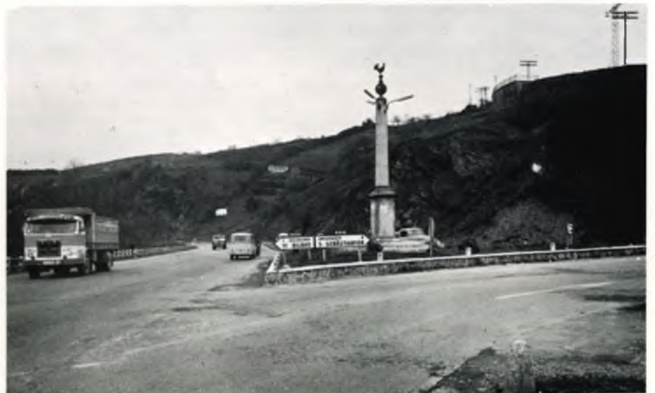
Intersección de la carretera N-834 con la N-240, El Gallo (Vizcaya).
