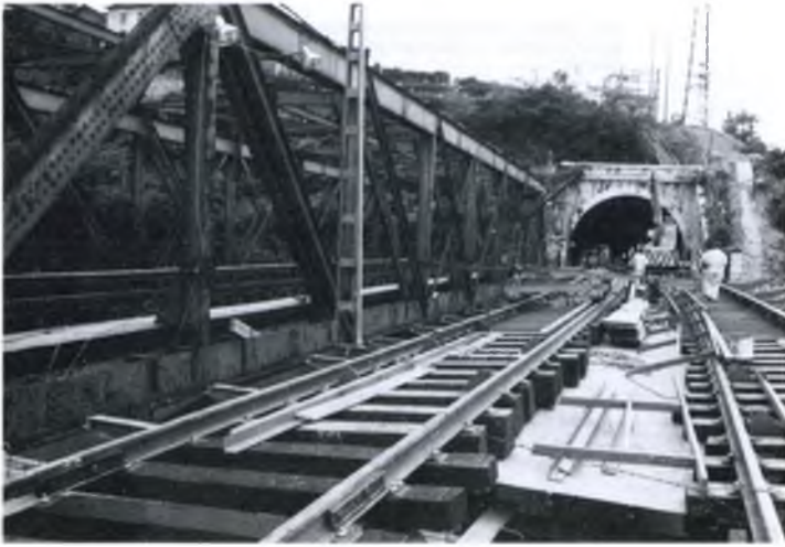
Obras en el puente de Hierro a su entrada en el túnel de Capuchinos
