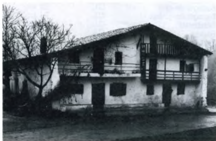
Vista general del caserío OTZATXULOETA. Cliche: Fermín de Leizaola 090276
