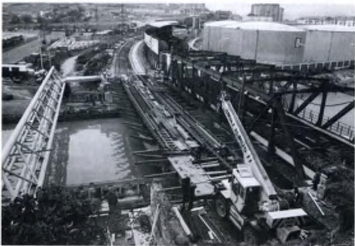
Obras en el puente de Hierro. Vista general
