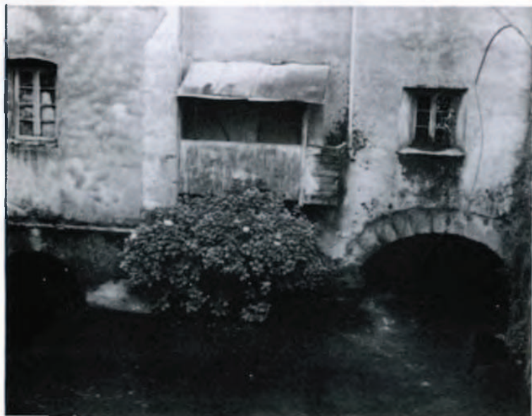
La Fanderia. Estado actual.
