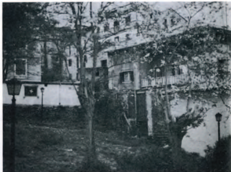
Vista del muro trasero de la casa de la cristalería (C) y la Sociedad Txepetxa, ocupando el lugar que antiguamente lo hizo la muralla.
