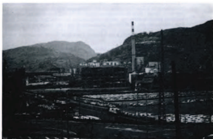
1988. Antes de la voladura del edificio Quiricasa.
