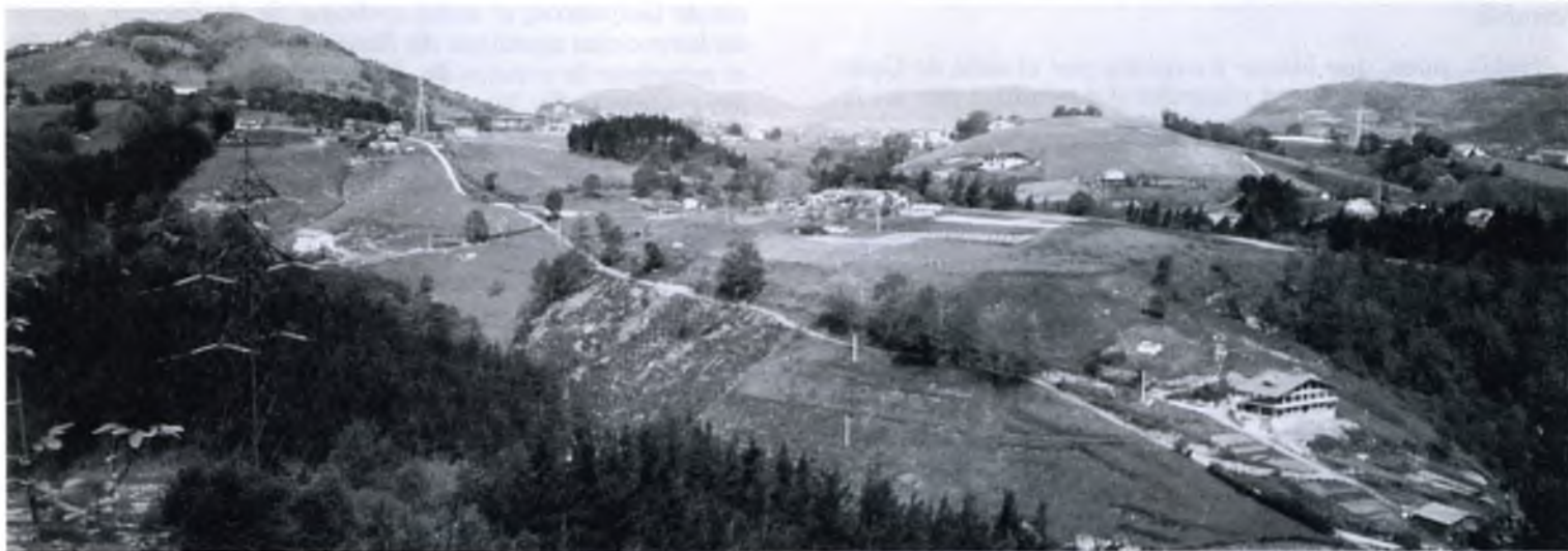
Fotografía obtenida desde Bunaundi. En ella se observa el trazado de “la Vía Marítima de Agrippa” en el trayecto —sentido ascendente— de proximidades de Epentza, ladera Sur de Larraburu y Elbitxuri; al fondo, San Marcos.
