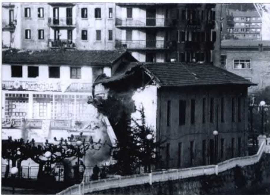
Derribo del Asilo Municipal el 14 de enero de 1988
