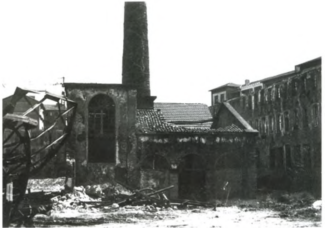
Derribo parcial de la Fábrica de Tejidos de Lino. Junio 1981.
