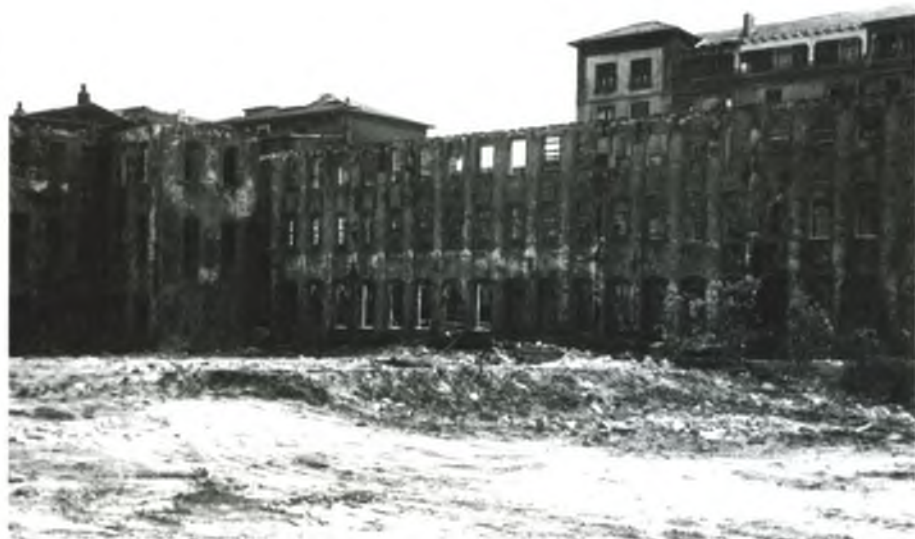
Derribo parcial de la Fábrica de Tejidos de Lino. Junio 1981.
