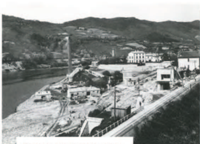
1950 comienzo de las obras. Vista de costado, desde lo que será el futuro mirador.
