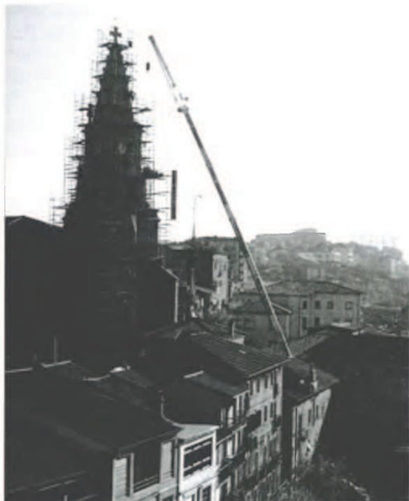
Obras en la Parroquia.
