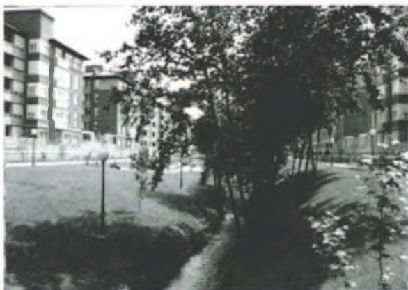
Parque y casas ya habitadas en el nuevo barrio de Fanderia.
