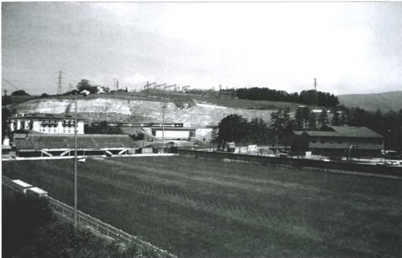
Campo de Larzabal. Debajo y detrás del tren obras de la variante de la N-1 por terrenos de Oiartzun, muga con Errenteria. (Mayo de 1998). (Fotografía: Jesús Hospitaler).
