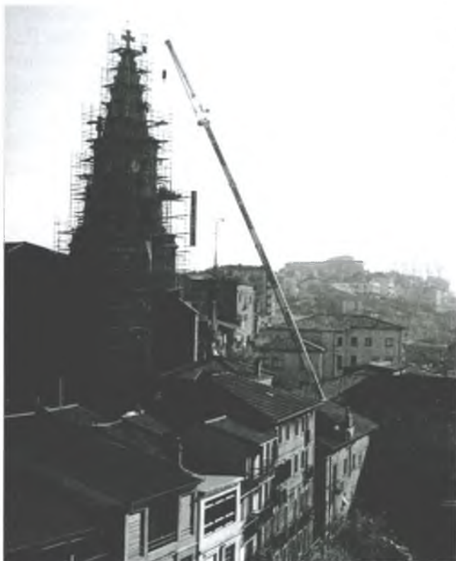
Obras en la Parroquia.
