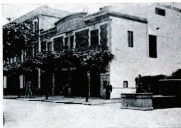
Vista de la fachada principal del Salón Reina Victoria. FOTO FIGUSKI
