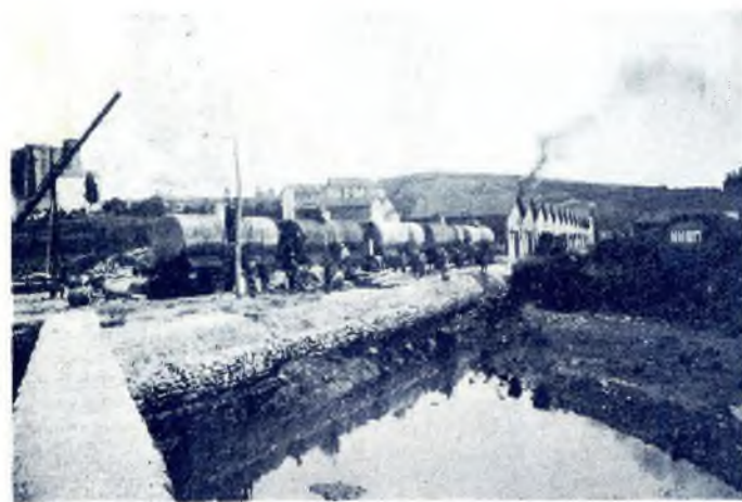
Vista general de los pabellones y muelles en construcción, propiedad de la Sociedad Almacenes de Lezo-Pasajes.
