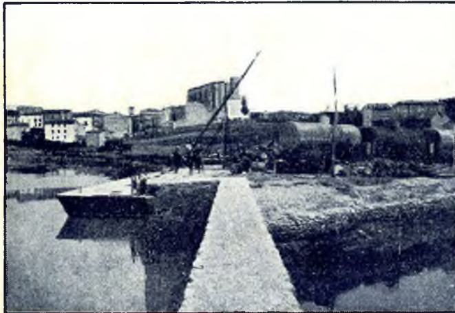
VISTA GENERAL DEL PUERTO DE LEZO, EN CONSTRUCCION
